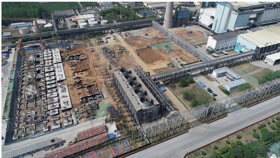
图 1.1-3 项目区现场照片
